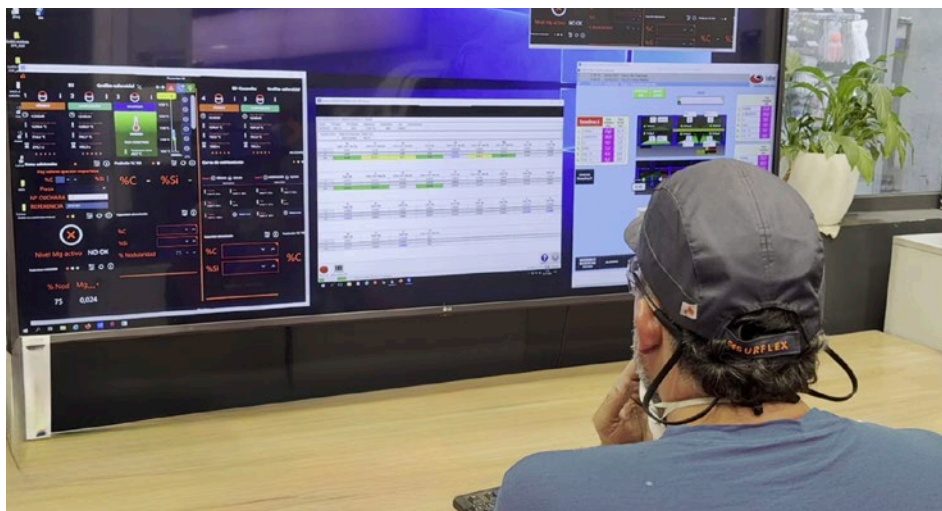
Figura 5. Pantalla de resultados del análisis térmico (Thermolan®) integrada con otros parámetros de control de la planta para la gestión y toma de decisiones
